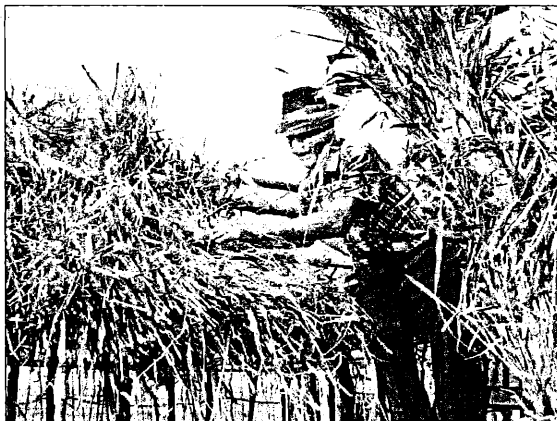
Fig. 29. Montarea acoperișului (Foto V. Cotiuță).
